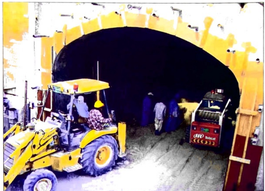
Bild 3: Abschnittswiseer Ausbau der Tunnelunterführung nach den Injektionsbohrungen
