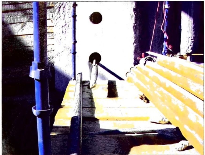
Bild 2: Austritt der Bohrlanze aus der Kernlochbohrung
