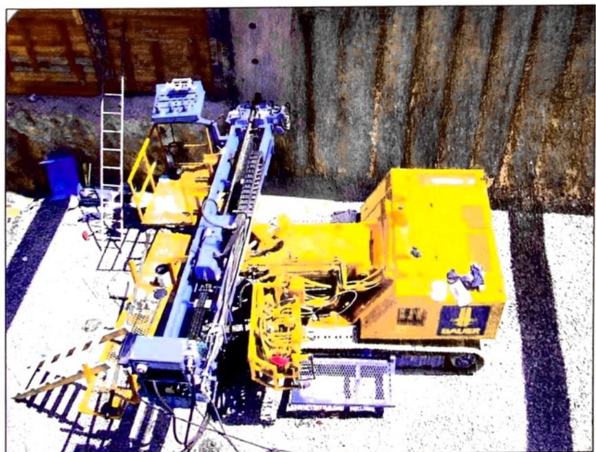
Bild 1: Herstellung der Pilotbohrung mit Grundodrill-Bohrlafette auf einem höhenverstellbaren Bauer-Fahrwerk
